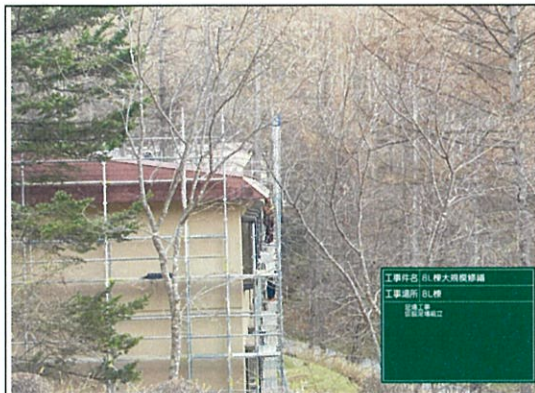
工事件名 01.棟大規模修繕 工事場所 01.棟 現場工事 執行日
