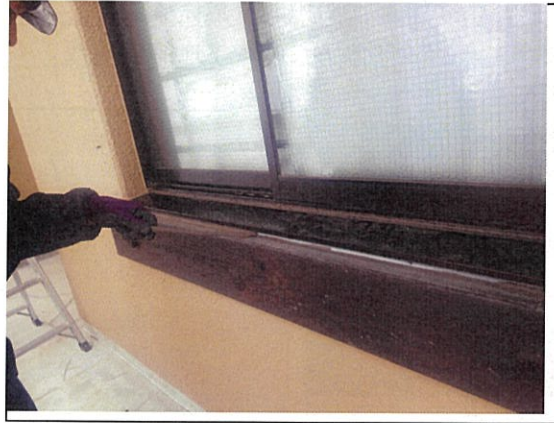
シーリング工事 シール撤去作業
