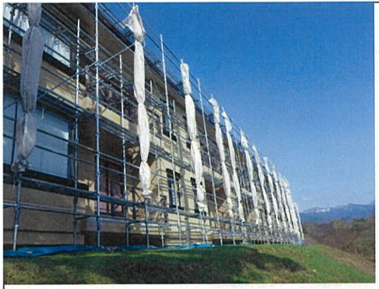
仮設足場 完成
