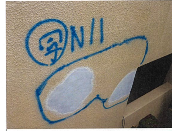
躯体補修 下地補修・完成
