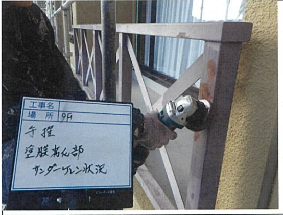
鉄部塗装工事 下地研磨
