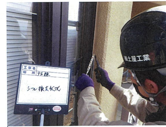
シーリング工事 シール撤去作業
