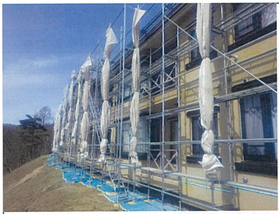
仮設足場 完成
