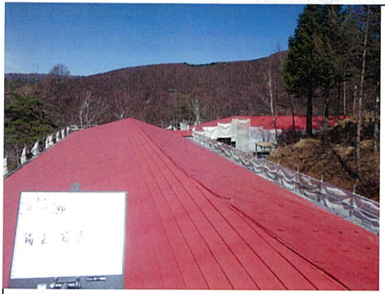
屋根工事 錆止め・下塗り完成
