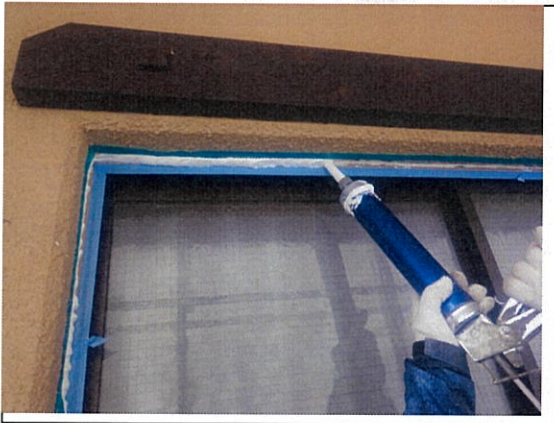
シーリング工事 シール打替え作業
