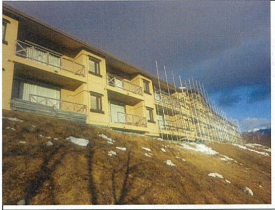
仮設足場 組立作業
