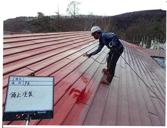
屋根工事 錆止め・下塗り作業
