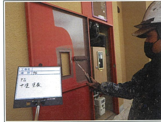
鉄部塗装工事 中塗り作業
