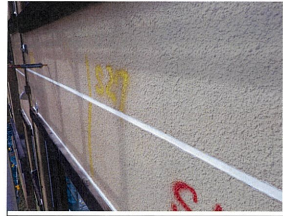
シーリング工事 シール打替え作業・完成
