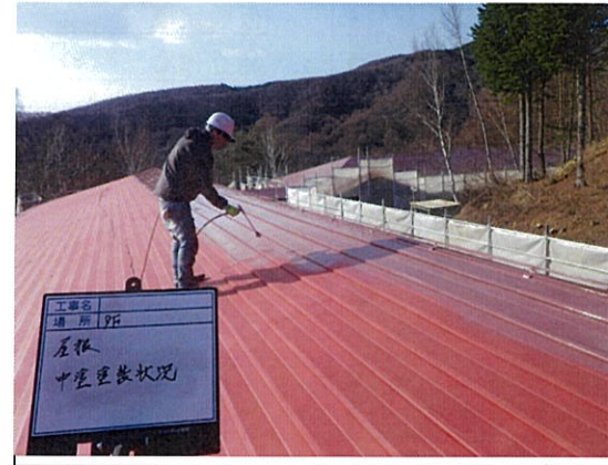
屋根工事 中塗り作業
