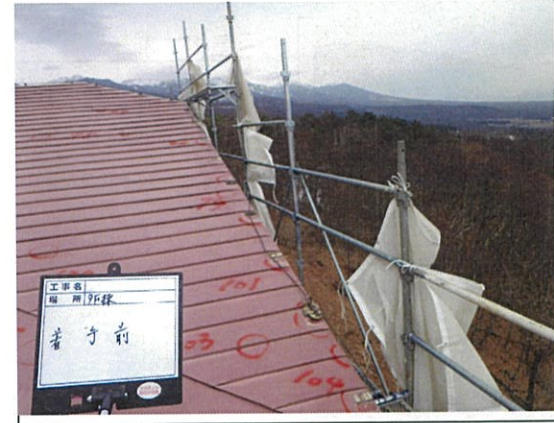
屋根工事 調査・不良箇所マーキング
