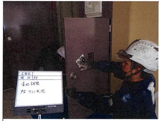
鉄部塗装工事 下地研磨
