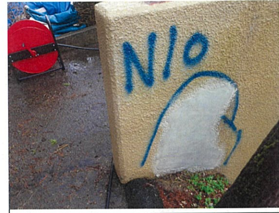
躯体補修 下地補修・完成
