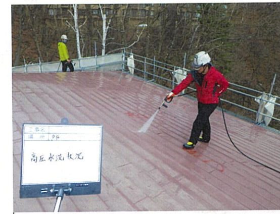
屋根工事 高圧水洗浄
