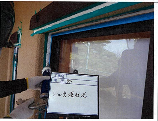
シーリング工事 シール打替え作業
