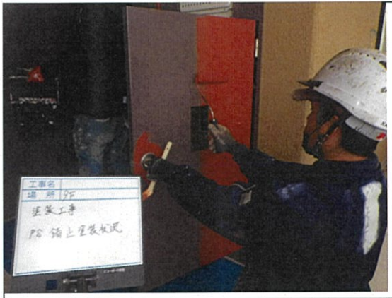
鉄部塗装工事 錆止め・下塗り作業
