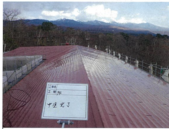
屋根工事 中塗り作業・完成
