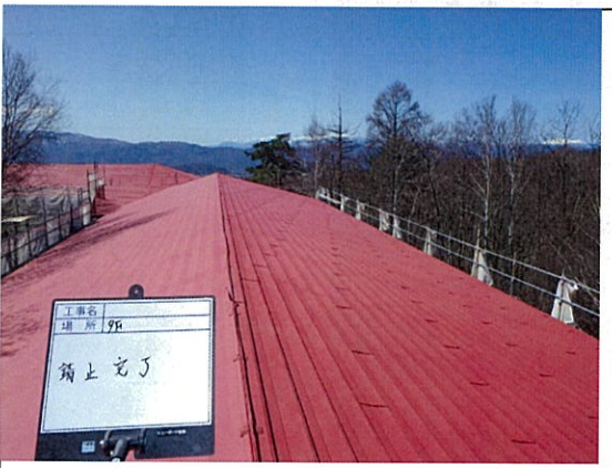
屋根工事 錆止め・下塗り完成
