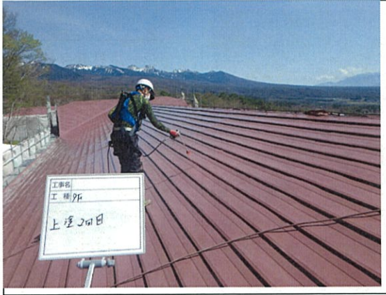
屋根工事 上塗り作業
