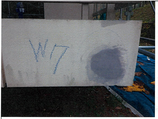
躯体補修 下地補修・完成
