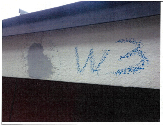
躯体補修 下地補修・完成
