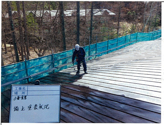
屋根工事 錆止め・下塗り作業
