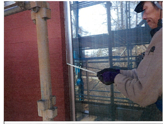
シーリング工事 シール撤去作業
