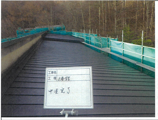
屋根工事 中塗り・完成
