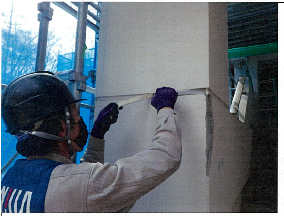
シーリング工事 シール撤去作業
