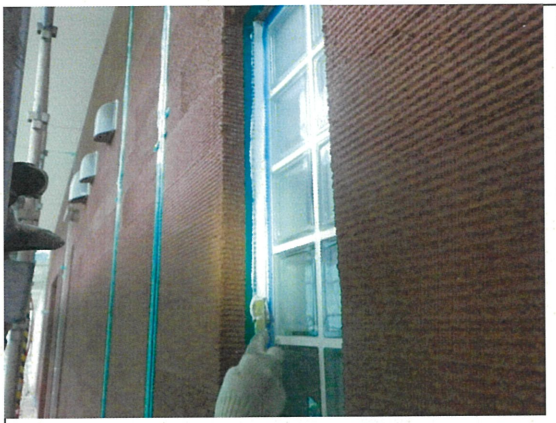
シーリング工事 シール仕上げ作業
