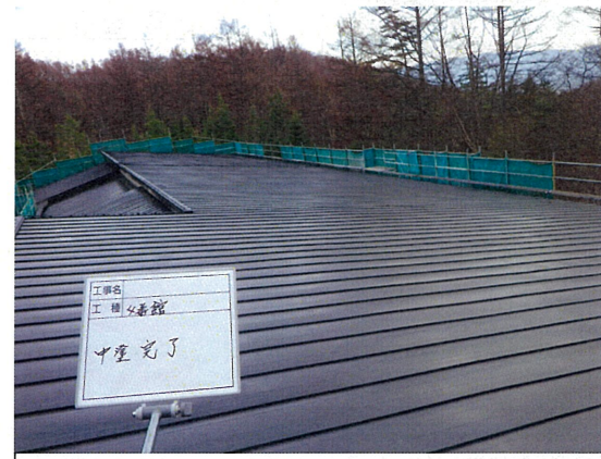
屋根工事 中塗り・完成
