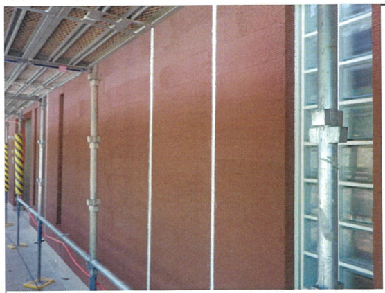
シーリング工事 完成
