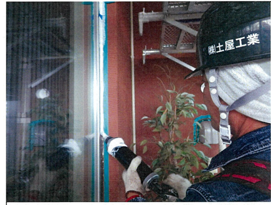
シーリング工事 シール打替え作業
