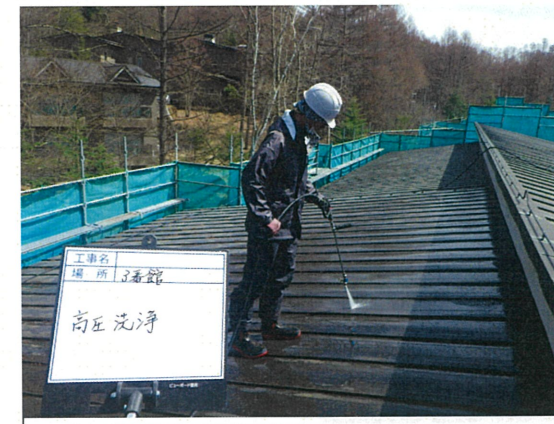
屋根工事 高圧水洗浄 _____
