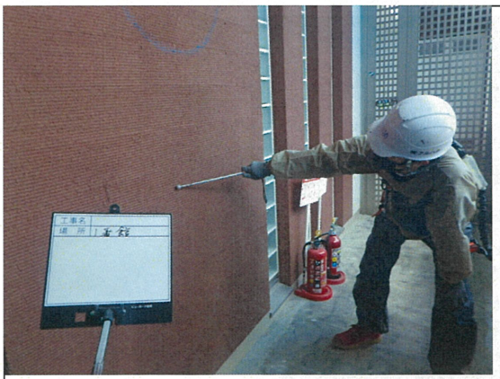
躯体補修 不具合箇所調査
