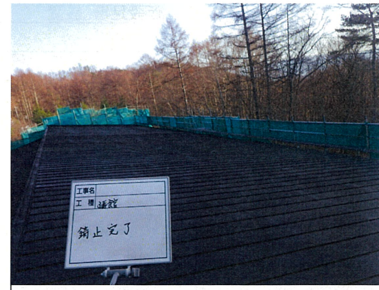
屋根工事 錆止め・完成
