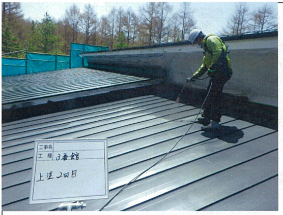
屋根工事 上塗り(仕上げ)・塗装作業
