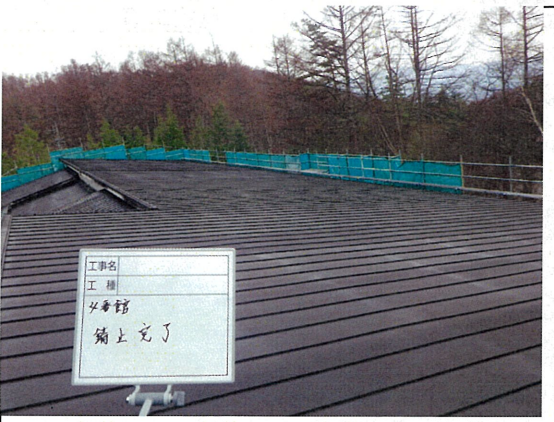
屋根工事 錆止め・完成
